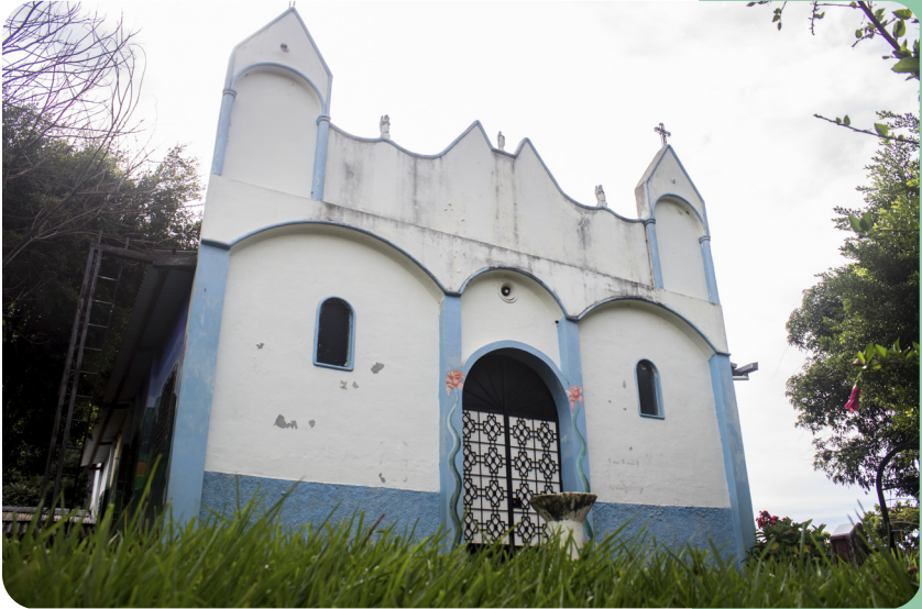
Iglesia de Los Tres Reyes Magos, destruida durante el conflicto armado y reconstruida luego de la firma de los Acuerdos de Paz.
